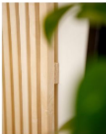
Rimaseinän tukipuu on leikattu vanerilevyistä.
